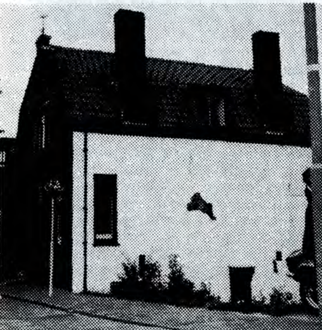
ogebouw in Oostburg.
